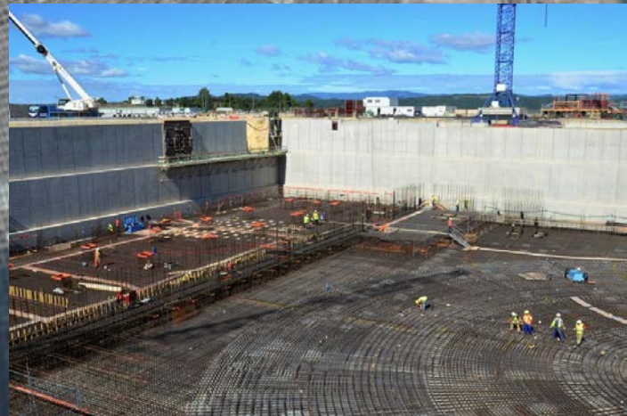
Betonijzer voor de tokamak hall
