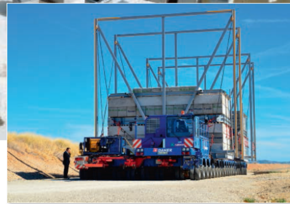
De eerste fase van de fundering van de fusiereactor. De 1,7 m hoge betonnen pilaren hebben een aardschokbestendige bovenkant.
