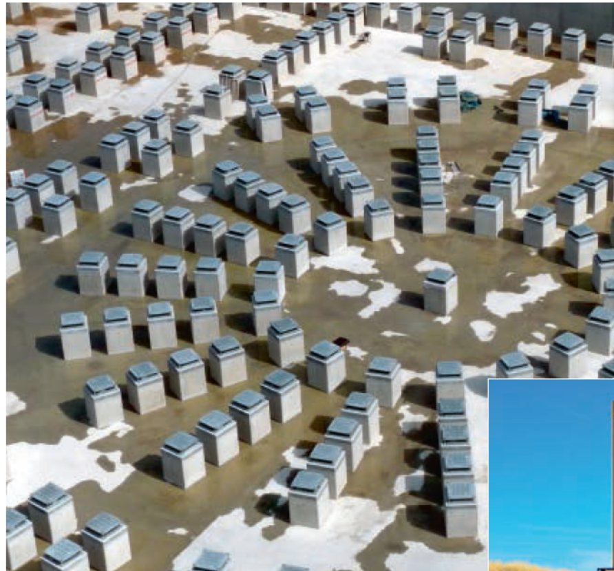
Het zestransport naar de bouwput van ITER met 800 ton aan betonblokken.
